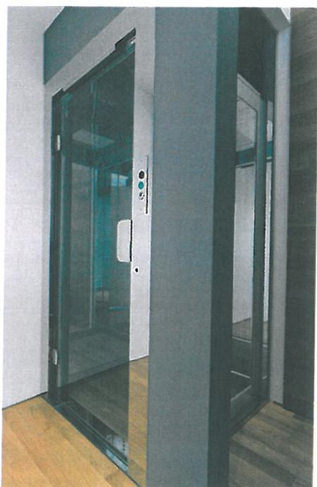
Per garantire un accesso indipendente alla casa direttamente dalla strada, si è creato uno spazio, seppur ridotto, nel quale è stato ricavato un vano ingresso con un ascensore in grado di superare il dislivello di circa 4 metri dove si trova l'appartamento. Per dilatare gli spazi del piano terra, la cabina dell'elevatore è in acciaio inox e cristallo trasparente.
